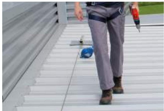
Le passage des potelets intermédiaires se fait sans se détacher à l'aide d'un chariot ou en se détachant avec un mousqueton.
