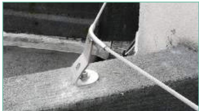
Le passage des potelets intermédiaires se fait sans se détacher à l'aide d'un chariot ou en se détachant avec un mousqueton.
