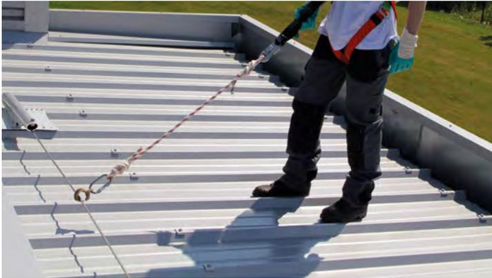
La ligne de vie est un support d'assurage flexible horizontal en acier inoxydable, qui s'utilise en installation à demeure. Elle s'adapte à tous types de parcours et de supports à l'aide d'ancres structurales (potelets, ancrages de façade,...) en acier galvanisé à chaud.
