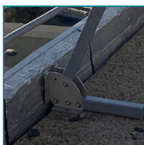
Système de fixation avec platine inox 316 et visserie inox A4
